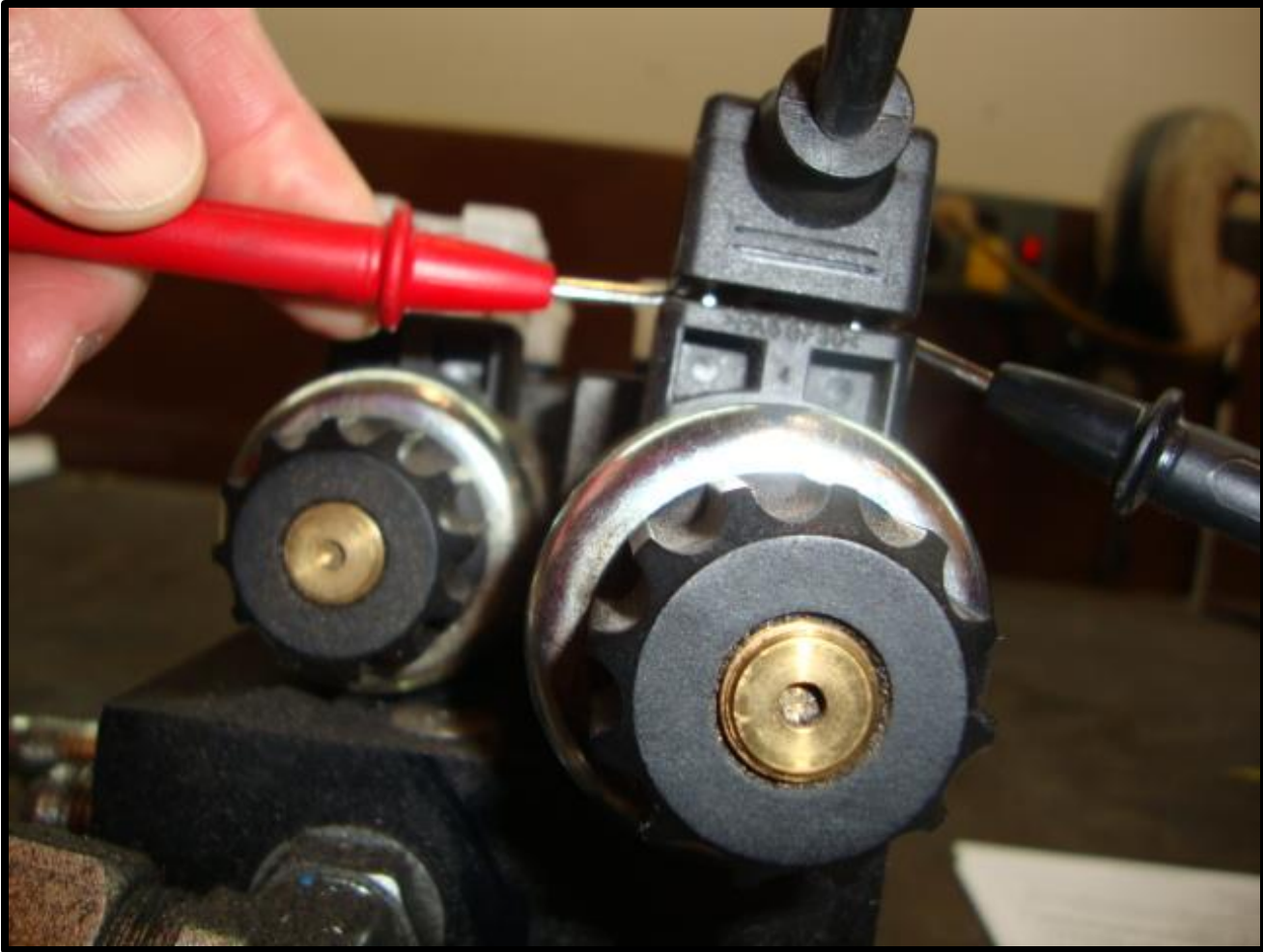
Fig. 8-4 Checking Din Plug Voltage
